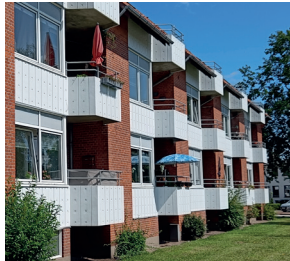
Udskiftning af vinduer
